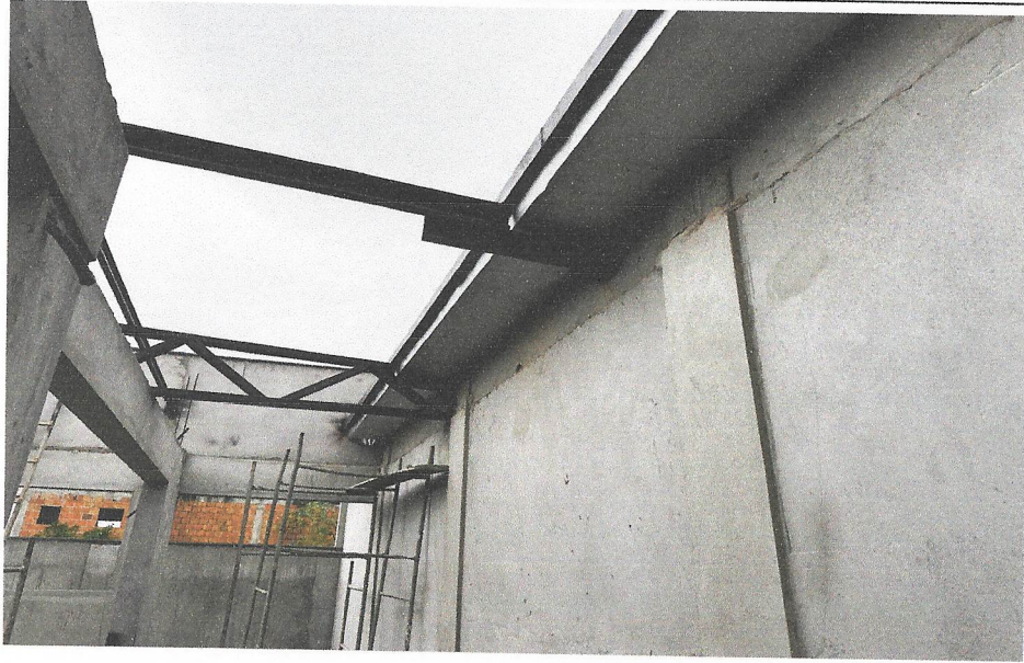
FOTO 85: CONFEÇÃO DE CALHA PLUVIAL
