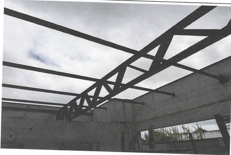
FOTO 83: ESTRUTURA COBERTURA METÁLICA
