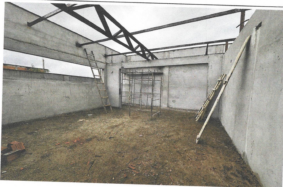
FOTO 84: ESTRUTURA COBERTURA METÁLICA
