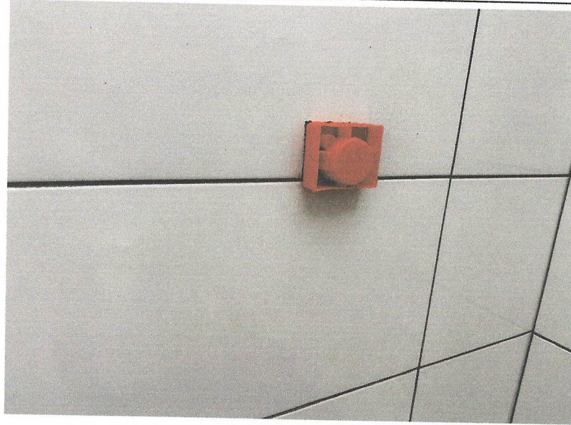
FOTO 93: INSTALAÇÃO VÁLVULA DESCARGA
